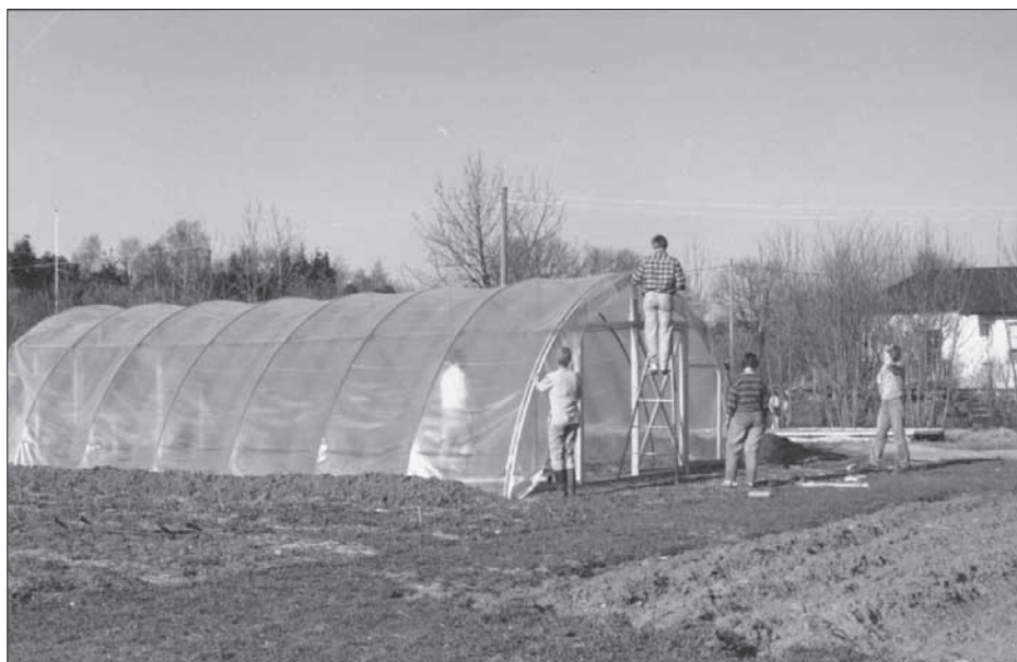
Bild på växthusbyggandet med hjälp av grannarna i Mejeriet.
